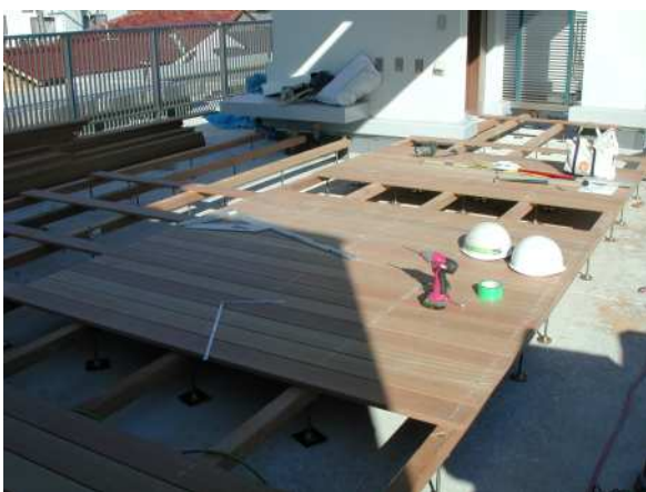
ウッドデッキの貼り込みをする
