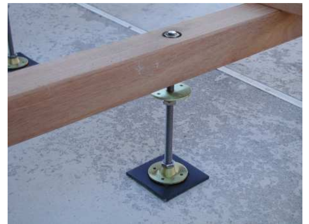
床とジョイストリフターの間にゴムシートを挟む
