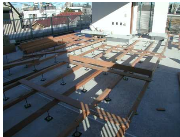
根太材を立ち上げて高さ調整をする
