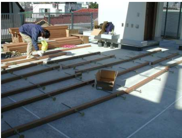
ジョイストリフターを根太材に差し込む
